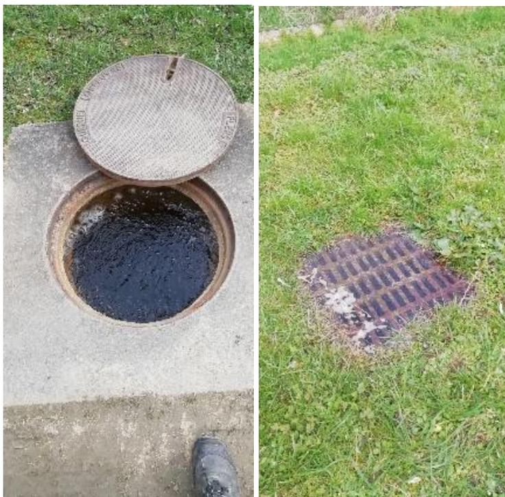
Un diagnostic a été mené sur le réseau pluvial du terrain, certainement bouché. Un passage caméra a été effectué sur 31 mètres linéaires. Il a été découvert des fissures dans le réseau et donc des amas racinaires à l'intérieur des canalisations d'évacuation.
