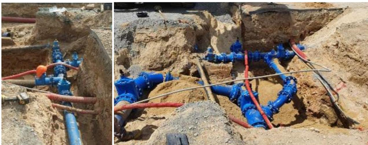
Les travaux de canalisation (voir photos ci-dessus) ont été effectués au cours de l'année 2022 avec la mise en place d'une conduite dédiée DN 250 mm entre le labo de Touraine et la bache de la Thibaudière. Des raccords restent à faire au sein de l'usine de la Thibaudière ainsi qu'une étude de dimensionnement des groupes de pompages.
